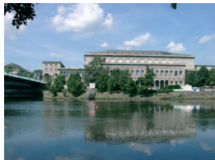
NETZTECHNIK-Projekt DECT-TK-System für die Stadthalle Mülheim
